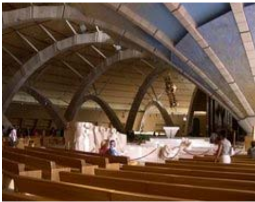
Particolare della copertura
