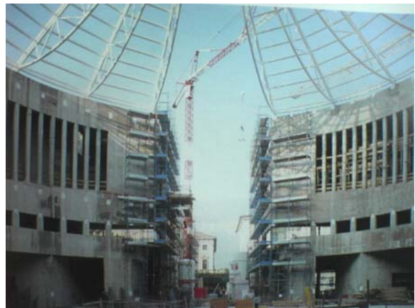
Fase di montaggio dei lucernari. La corte a getto completo
