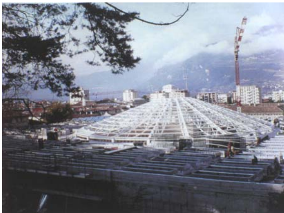
Assemblaggio delle strutture portanti
